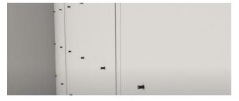
Mettre la colle à base de platre par plots sur le panneau à terre ou bien utiliser de la colle en polyuréthane à faible expansion
