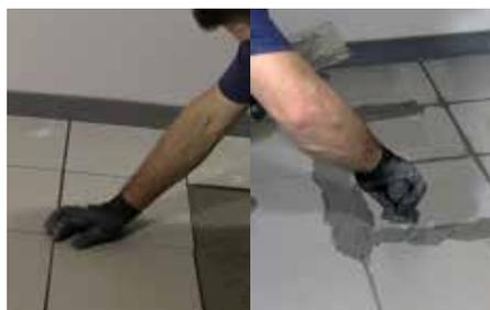
Effectuer la jointure des carrelages. Nettoyer la surface des carrelages lorsque le mastic commence à durcir
