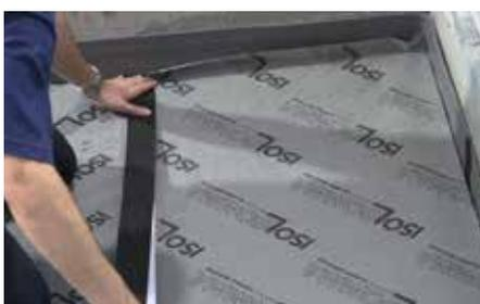
En l'absence du rabat adhésif, sceller les joints avec du ruban adhésif. Toujours vérifier que le tapis est correctement installé et sans déchirures
