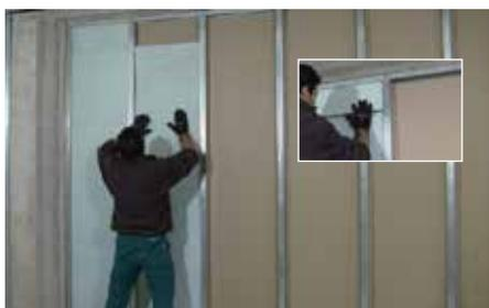
Insérer les panneaux dans le cadre métallique
