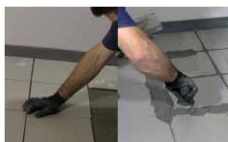
Jeter la colle et poser les carrelages. Appliquer la jointe et nettoyer les carreaux de céramique
