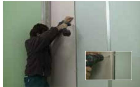
Recouvrir la couche isolante en vissant les deuxièmes plaques de plâtre sur les goujons métalliques
