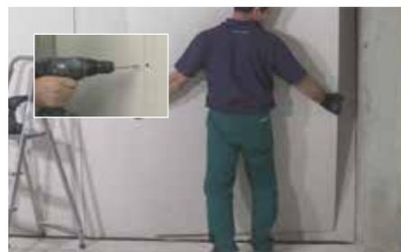
Après 2/3 heures, fixer le second panneau de plâtre en le vissant sur la ligne centrale et sur le côté bordures avec vis à double filetage.
