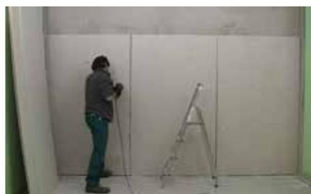
Après 30 minutes percer le produit et le mur derrière avec 6 trous par panneau et appliquer le long Fixation.
