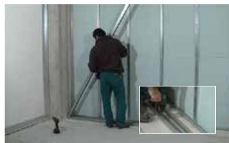
OPTIONS: réaliser la deuxième structure métallique pour créer une paroi double et fixer la seconde plaque de plâtre en la décalant de la première
