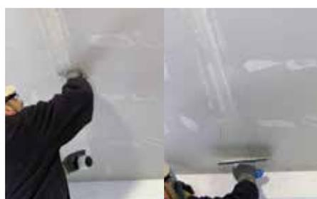
Appliquer le ruban de maille en plastique sur les plaques de plâtre pour joindre les lignes et les plâtrer
