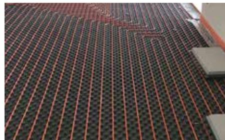
Si dans le cas d'un système de chauffage, poser le panneau de chauffage au-dessus de la couche d'isolation acoustique
