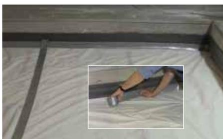
Placer une couche/pellicule de protection. Protéger précisément les côtés de la surface et les jonctions avec le ruban adhésif
