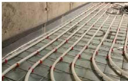
Dans le cas du sol radiant, posez le filet et le tuyau de chauffage au sol
