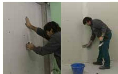
Appliquer le ruban de plastique dans le lignes de jointage des plaques de plâtre et les jointoyer
