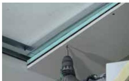
Fixer le panneau au cadre métallique avec des vis de 55 mm tous les 15 cm
