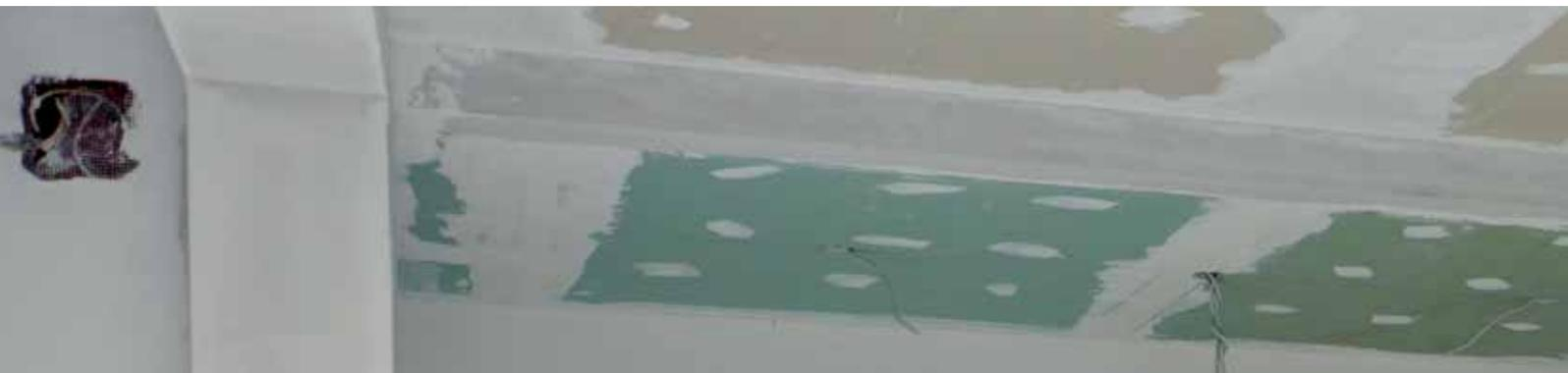
Pour la pose correcte des produits de plafond il faut installer le cadre métallique. En utilisant le système klik-on ou support universel, il peut être abaissé de 3 à 12 cm.
