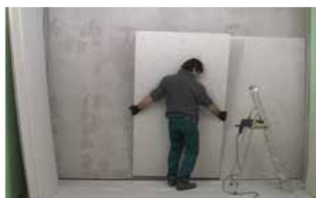
Appliquer le panneau sur le mur en forçant avec une pression homogène
