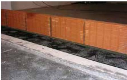
Construire la première rangée de briques sur la bande Stywall, avec une couche de mortier entre les briques et le tapis de caoutchouc
