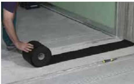
Poser la bande sous le mur. La bande doit être plus large que les épaisseurs de paroi d'au moins 2 cm par côté
