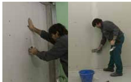
Appliquer le ruban de plastique dans les lignes de jointage des plaques de plâtre et les jointoyer.
