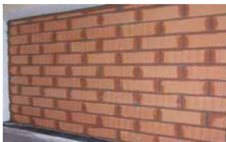
Construire le mur, en prenant soin de sceller les blocs avec mortier sur les joints verticaux et horizontaux
