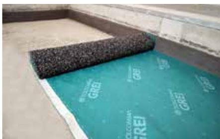
Poser la couche isolante sur la surface du sol avec les granules de caoutchouc face cachée
