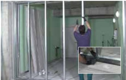
Fixer les goujons métalliques verticaux au plafond et guides de fond par vissage
