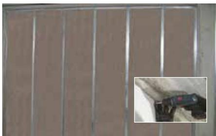
Fixer les plaques de plâtre sur un côté
